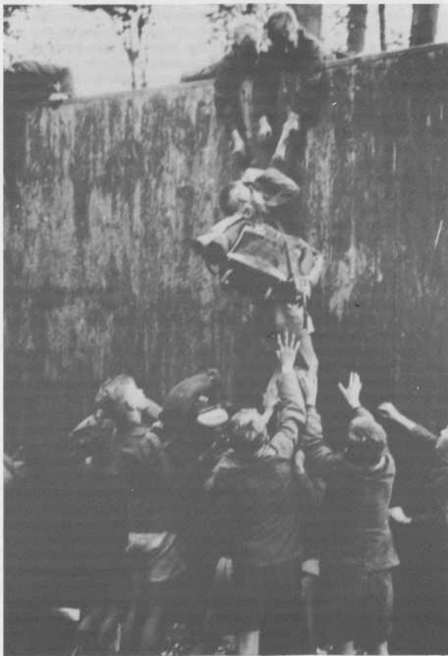
Abb. 12: Eskaladierwand der Hindernisbahn an der Nübbelallee
