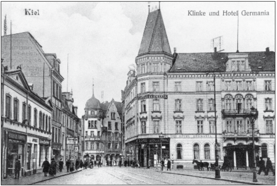
Das „Hotel Germania“, später „Haus Germania“ und Sitz der NSDAP-Gaugeschäftsstelle. In der Bildmitte mit dem runden Dach: Klinke 21.
